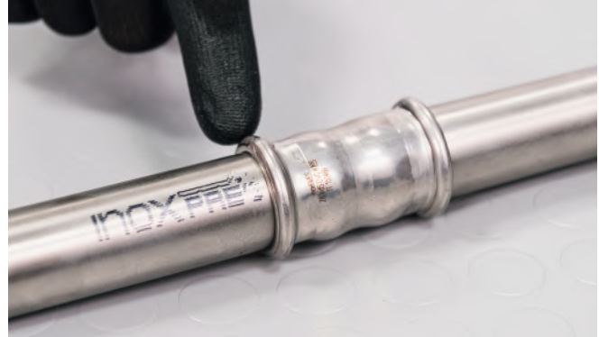
Bild 33 – Kontrolle der Pressverbindung
