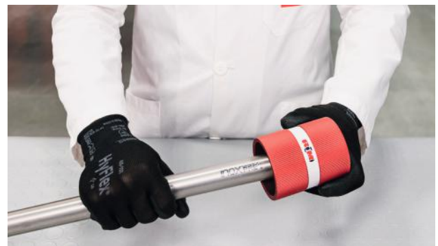
Bild 26 – Entgraten des Leitungsrohres
