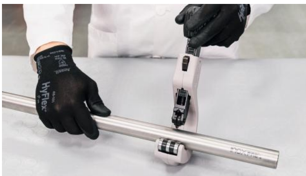
Bild 25 – Ablängen des Leitungsrohres
