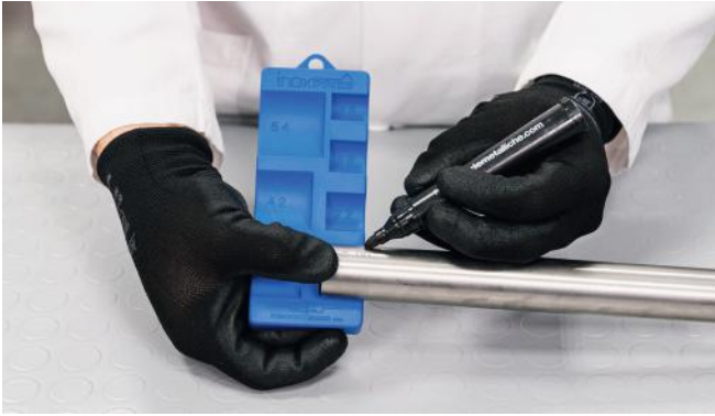
Bild 28 - Markieren der Einstecktiefe
