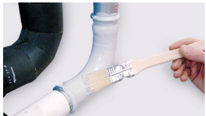
Bild 37 – Anstricharbeiten von Anschlussstücken und Rohrleitungen mit Grundierung
