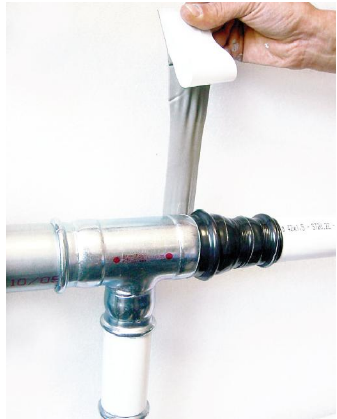
Bild 38 – Schutz der Anschlüsse mit Butanolklebeband.
